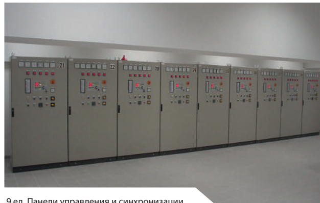
9 ед. Панели управления и синхронизации
