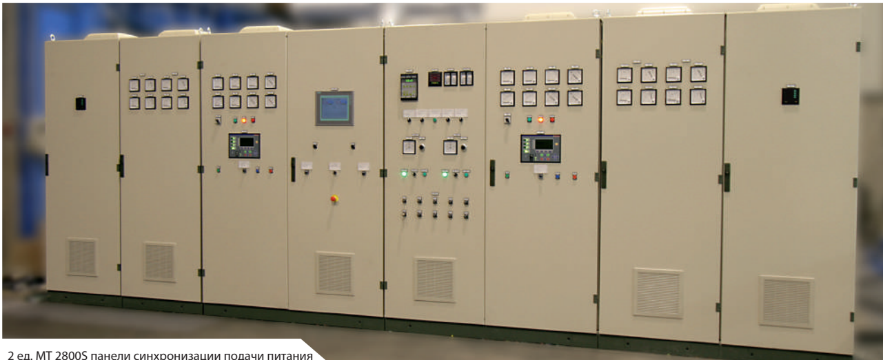
2 ед. МТ 2800С панели синхронизации подачи питания
